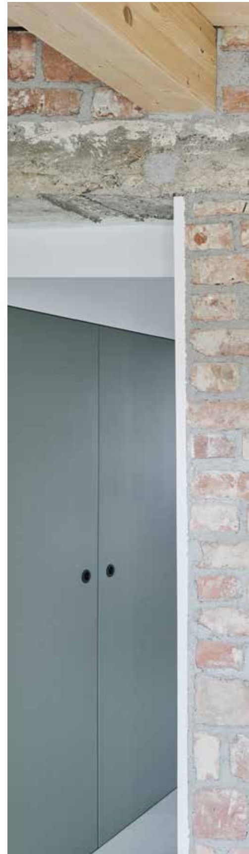
Die freigelegte alte Mauer zeigt die Selbstbauarbeit der ursprünglichen Siedler. The exposed old wall is a document of the self-construction of the 1920s cooperative.
